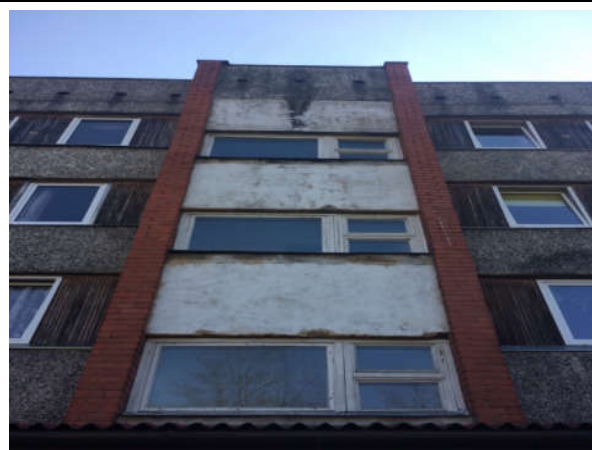
32. att. Kāpņu telpas koka logi neatbilst standartam LBN 002-15 "Ēku norobežojošo konstrukciju siltumtehnika". Ieteicams nomainīt.
