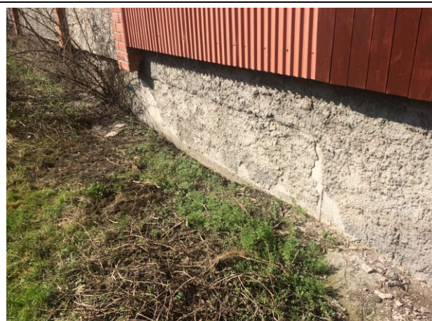
34. att. Pēc cokola/virspamata siltināšanas izbūvēt jaunu ēkas apmali ar kritumu no ēkas.
