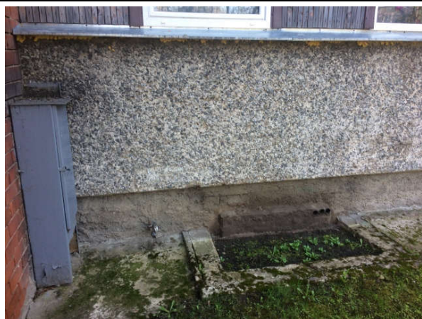
31. att. Pirms siltināšanas nepieciešams atvērīt sadalni, lai pilnā plaknē varētu nosiltināt fasādi. Pēc cokola/virspamata siltināšanas izbūvēt jaunu ēkas apmali ar kritumu no ēkas.
