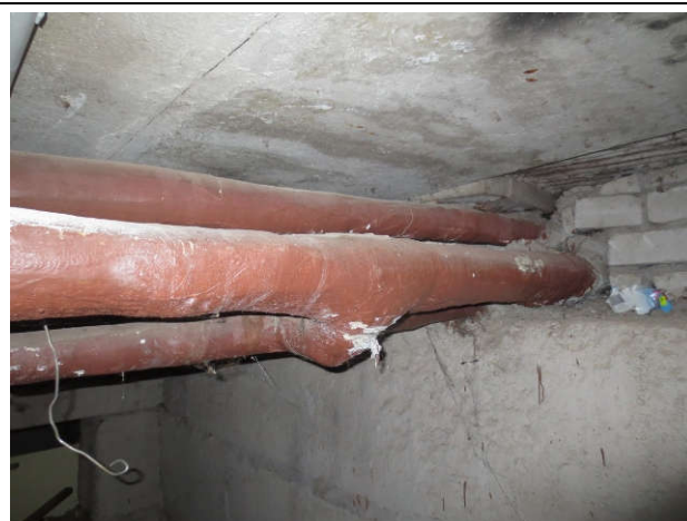
22. att. Pagraba cauruļvadu izlācija. Ieteicams nomainīt nolietojušos cauruļvadus un cauruļvadu izolāciju pret armētu alumīnija foliju pārklātām akmens vates čaulām, b=40 un b=50 mm.
