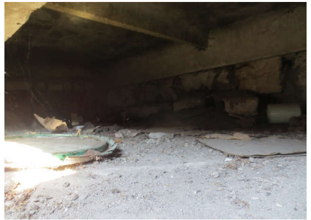
12. att. Tehniskā bēniņu telpa.
