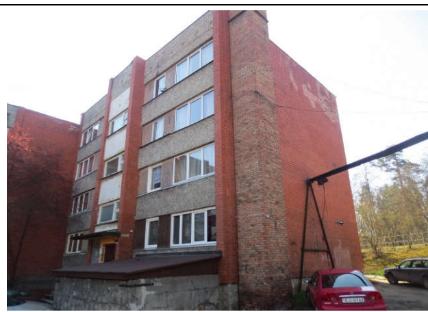
2. att. Rietumu un ziemeļu fasādes.
