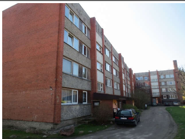
5. att. Ziemeļu un rietumu fasādes.
