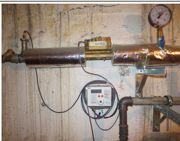
27. att. Siltummezgla kontroles un vadības bloks.
