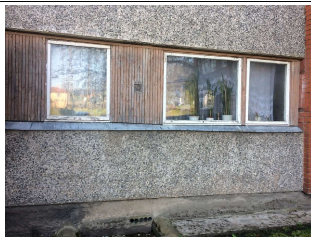
30. att. Dzīvokļa koka konstrukcijas logi neatbilst standartam LBN 002-15 "Ēku norobežojošo konstrukciju siltumtehnika". Ieteicams nomainīt.
