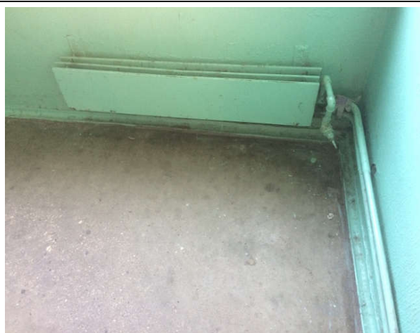
29. att. Kāpņu telpas sildķermenis.
