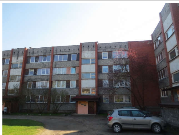
3. att. Ziemeļu un rietumu fasādes.
