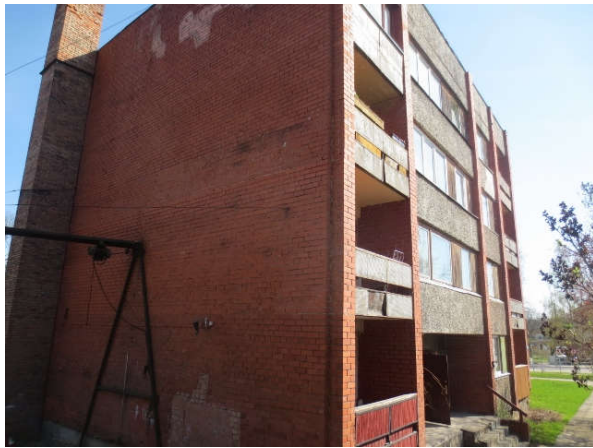
11. att. Dienvidu un rietumu fasādes.
