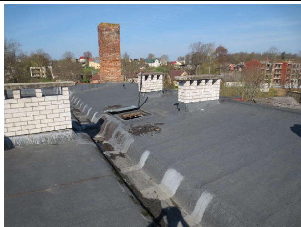
20. att. Vietām ieklāts jauns jumta hidroizolācijas slānis.
