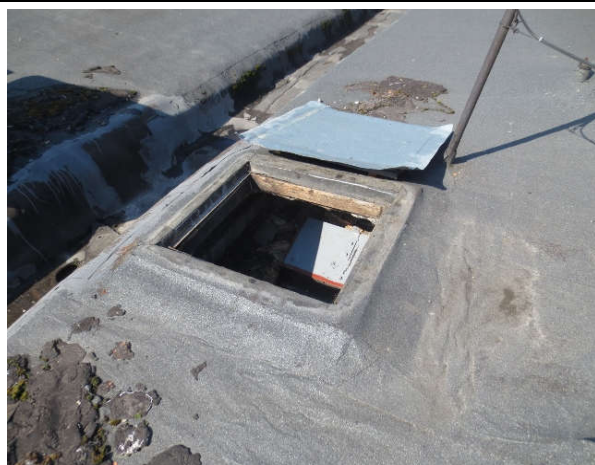
19. att. Jumta lūku un lūku uz tehniskajiem bēniņiem nepieciešams nomainīt pret jaunām.
