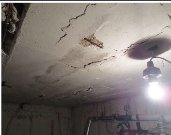
25. att. Pirms pagraba griestu siltināšanas nepieciešams novēst defektus.
