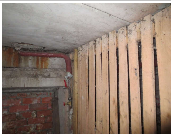
21. att. Pirms pagraba griestu siltumizolācijas ieklāšanas koka starpsienu augstumu samazināt pa siltumizolācijas biežumu.
