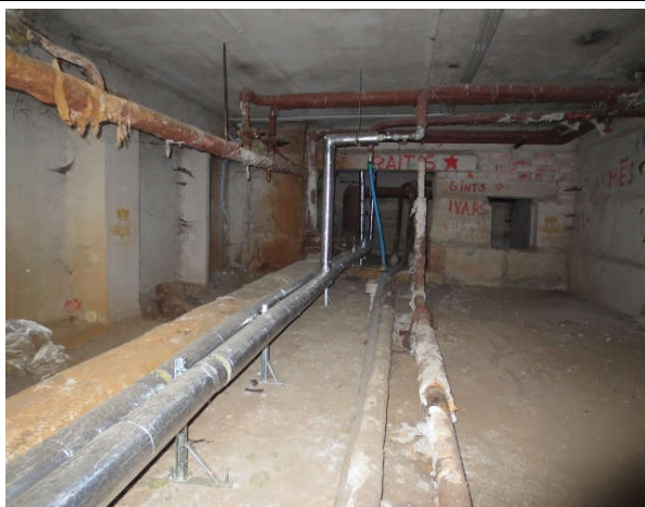
23. att. Pagraba cauruļvadu izlācija. Ieteicams nomainīt nolietojušos cauruļvadus un cauruļvadu izolāciju pret armētu alumīnija foliju pārklātām akmens vates čaulām, b=40 un b=50 mm. Nomainīta karstā ūdens cauruļvadu izolācija.
