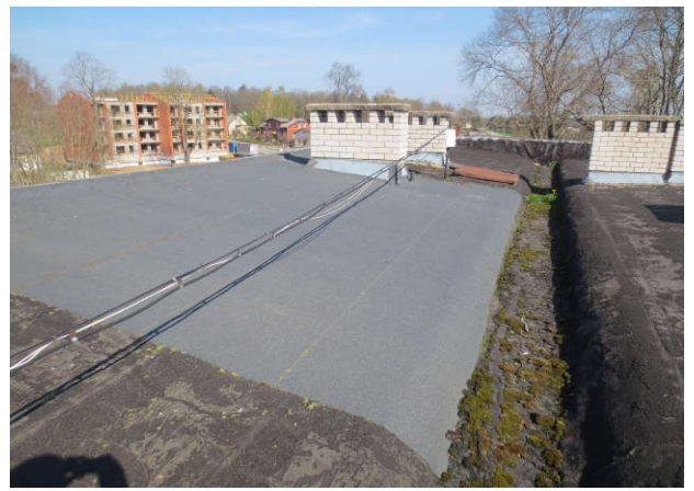
14. att. Vietām ieklāts jauns jumta hidroizolācijas slānis.
